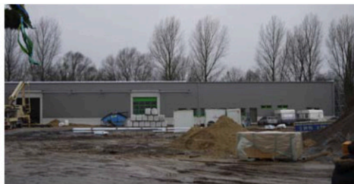
Nur drei Monate und einen Tag hat es gedauert, bis der Rohbau fertig wurde. Zeit fr das Richtfest
