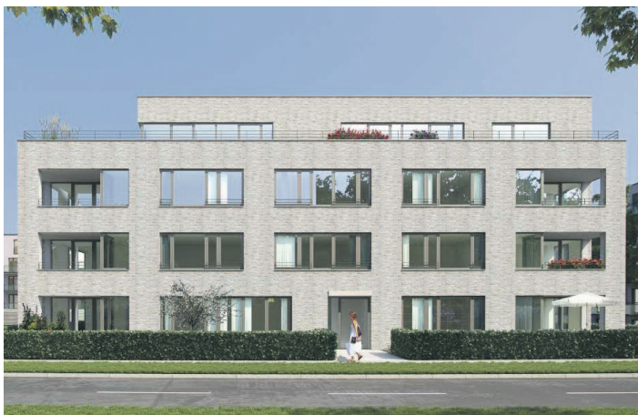
Die Südansicht vom „Tartuer Tor“ – das Wohngebäude.
