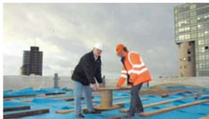
Wolfgang Ziegler (l.) und Olav Bruhn kontrollieren die Abdeckung Foto: Gipp
